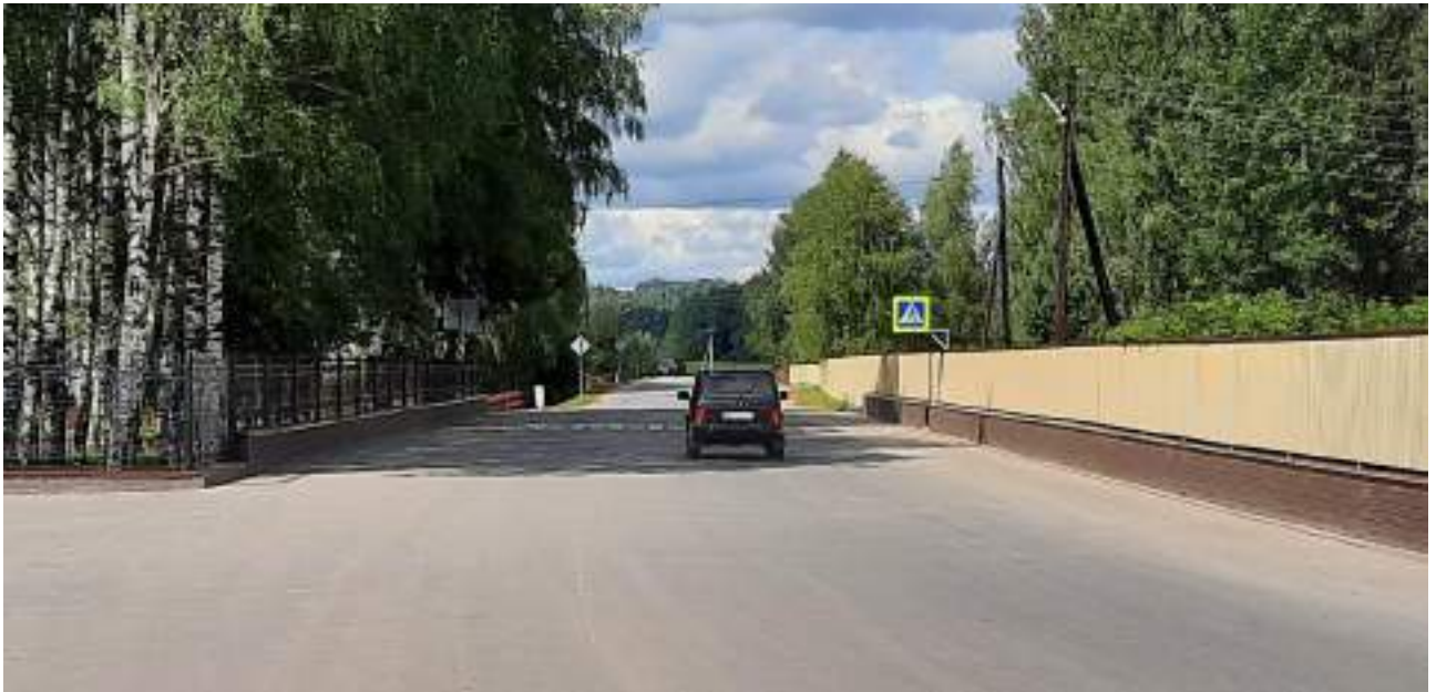
Рисунок 3.1 – Пешеходный переход в с. Березник, не соответствующий п.5.6.30 ГОСТ Р 52289-2019
